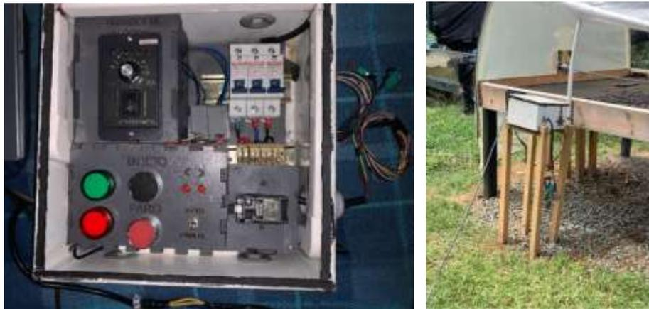
**Figura 47. Caja de control y estructura de montaje.**
