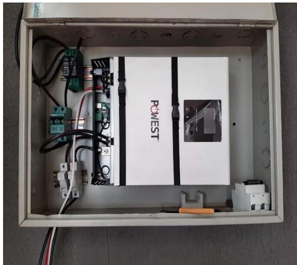
*Imagen 13 Conexiones del inversor Híbrido Powest*
