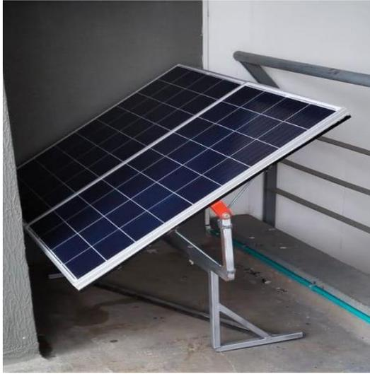
*Imagen 12 Posicionamiento de Paneles fuente: propia*
