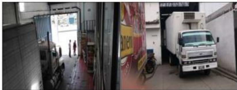
Imagen 11. Evidencia de zona de ingreso deficiente (sin acceso peatonal)
