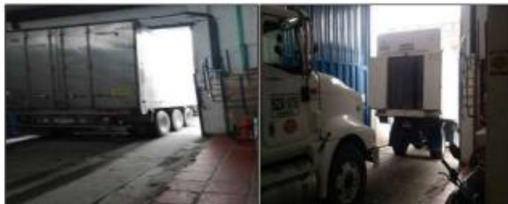
Imagen 12. Evidencia de Zona de ingreso deficiente (sin acceso peatonal)
