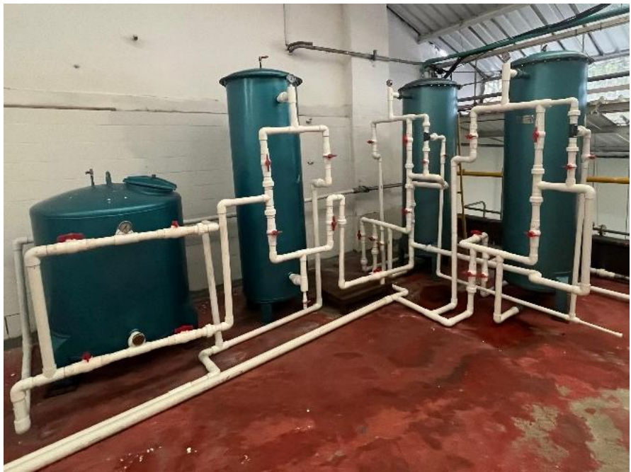
Imagen 27 Conjunto de filtros-suavizador. Fuente: Autor.
