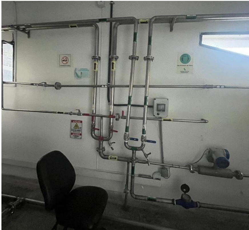
Imagen 30 Tablero de válvulas de preparación de aguardiente. Fuente: Autor.
