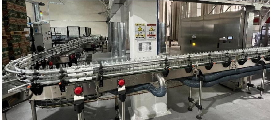
Imagen 48 Extracción de envase en mal estado de la banda L-2. Fuente: Autor.
