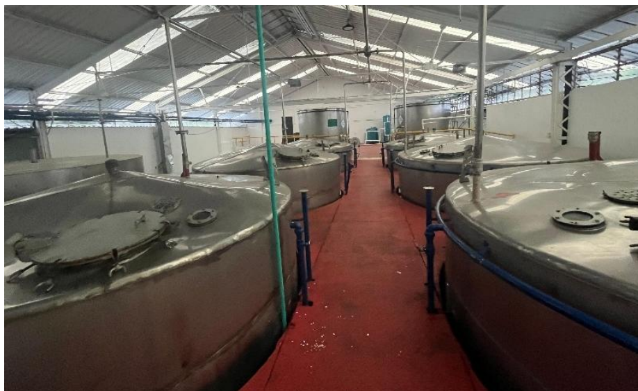
Imagen 24 Tanques de almacenamiento de alcohol (3/3). Fuente: Autor.
