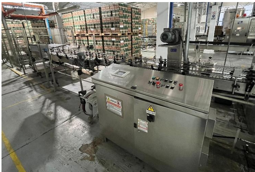
Imagen 39 Panel de operación. Fuente: Autor.
