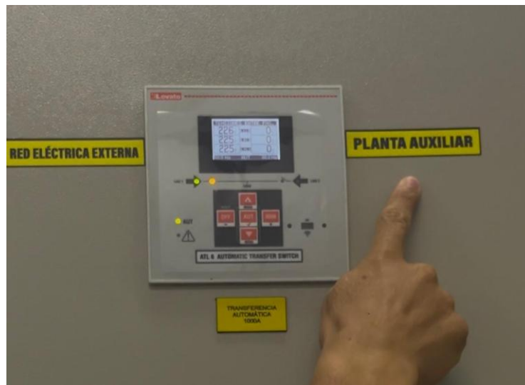
Imagen 14 Panel de transferencia (exterior) Red externa-Planta auxiliar. Fuente: Autor.
