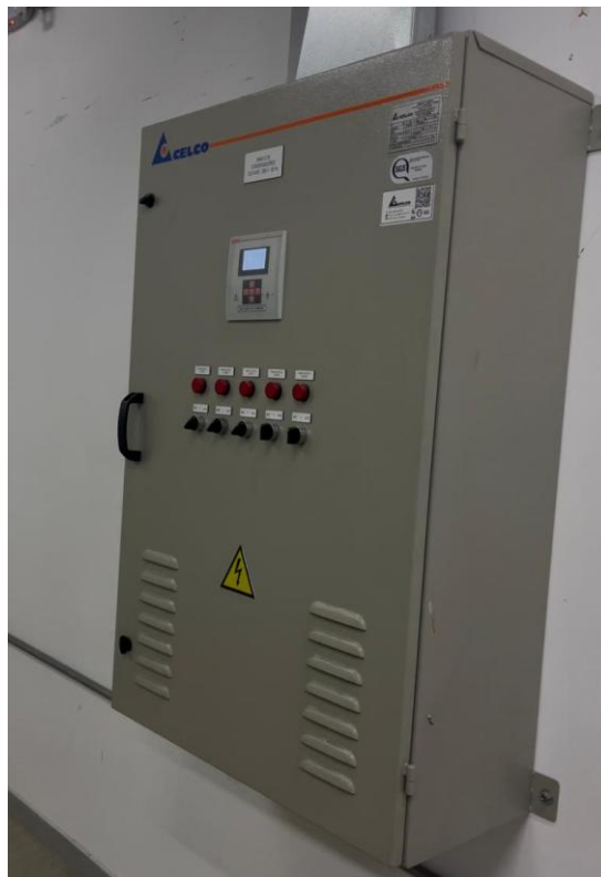
Imagen 12 Banco de condensadores. Fuente: Autor.
