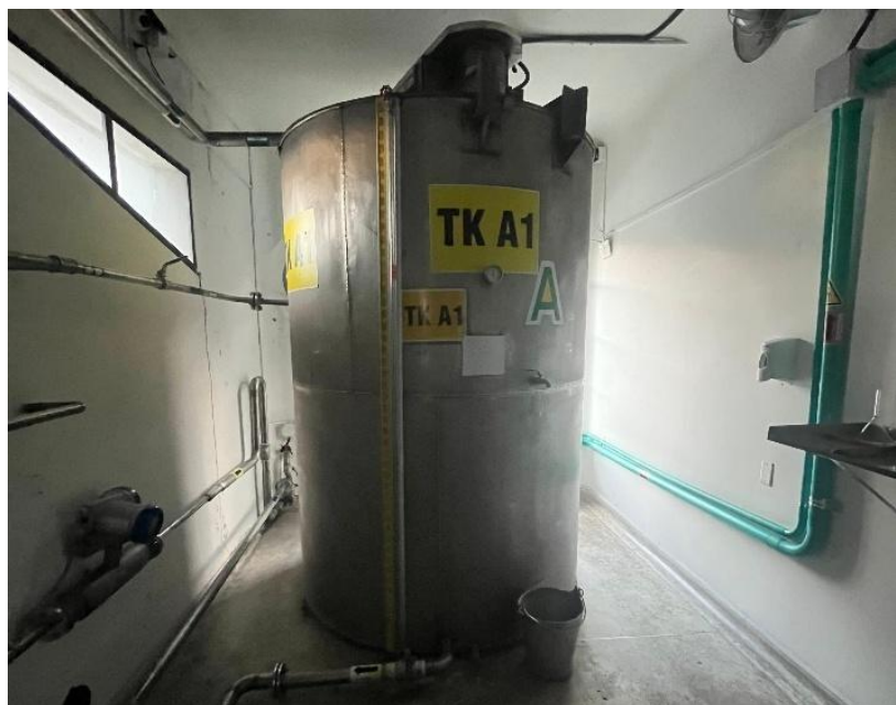
Imagen 31 Tanque A de preparación de aguardiente. Fuente: Autor.
