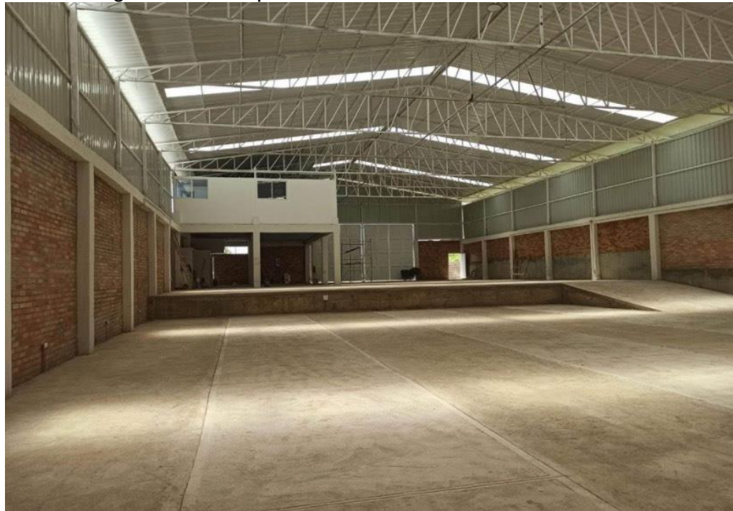
Figura 32. Bodega barrio la esperanza.
