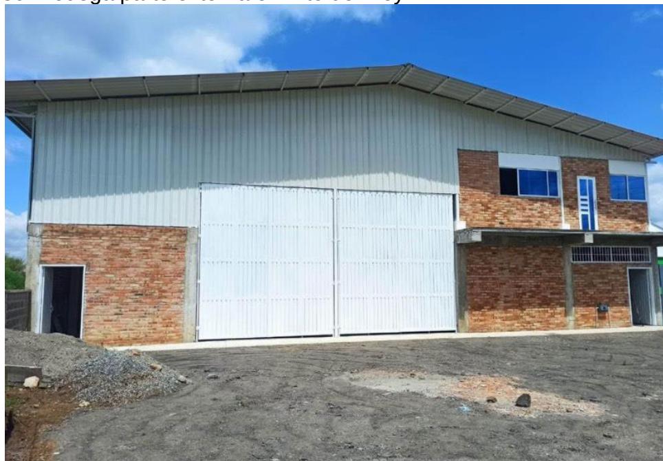
Figura 30. Bodega parte externa en Alto del Rey.
