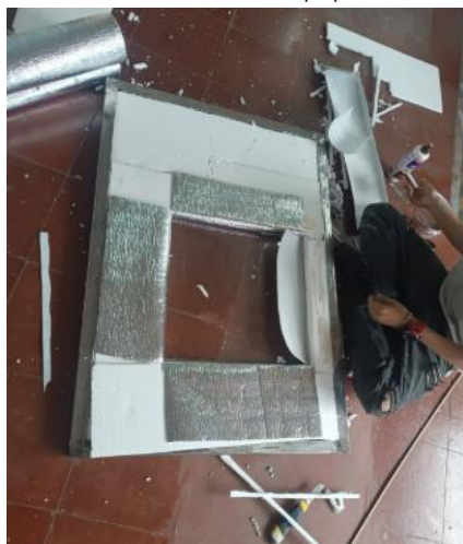
Figura 67. Rellenado de poliestireno expandido de 1m de grosor la estructura metálica.
