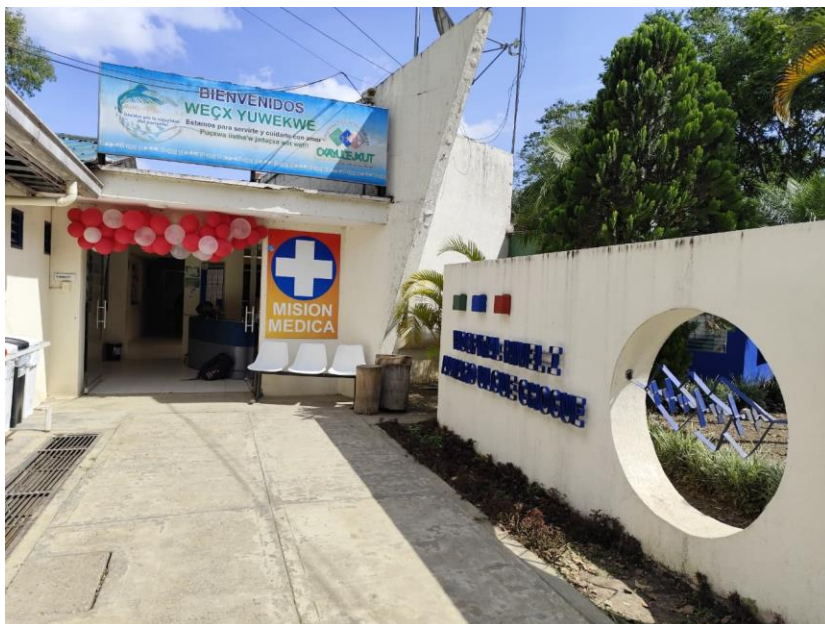
Ilustración 26 Entrada hacia las instalaciones de la E.S.E. Cxayuce Jxut
