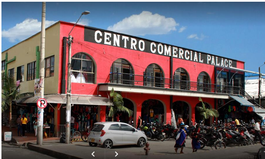
Ilustración 22 foto panorámica centro comercial PALACE
